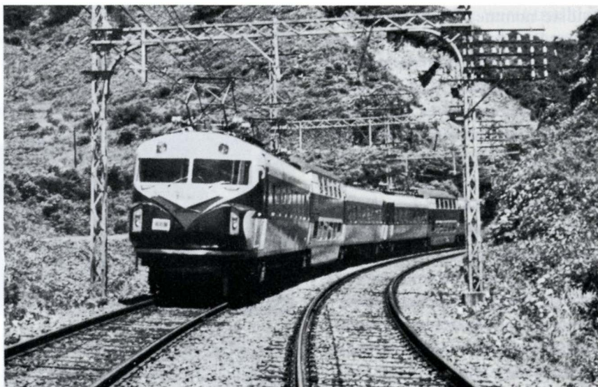
Det private Kinki Nippon baneselskab har mange linier i Osaka-Kyoto-Nagoya området. Sporvidden er det europæiske normalspor. Disse baner afvikler en vældig trafik. Billedet viser et eksprestog, der er formeret af tre enheder, som hver består af to endevogne med banemotorer og en mellemvogn uden motorer. Mellemvognen har to etager.
