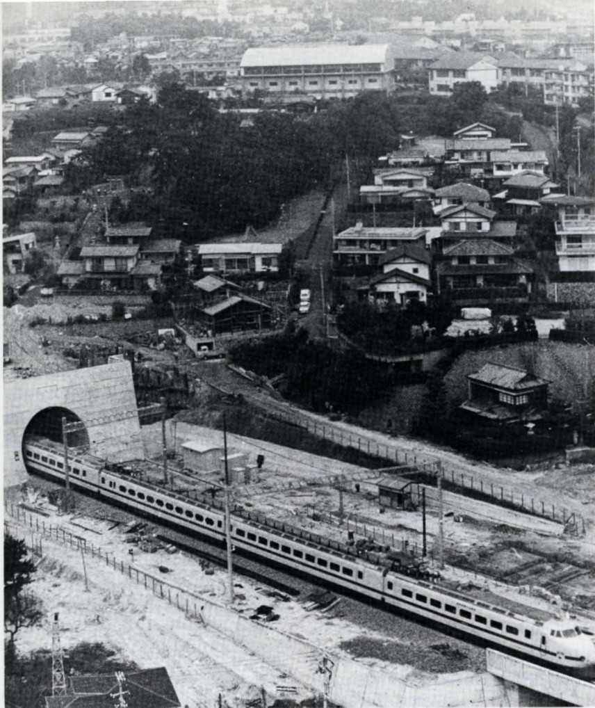
Længste JNR enkelttunnel bliver Tsugaru-anlæggets – 53,85 km, ventes klar i 1983. Blandt færdige tunnelanlæg: 57 km af Shin–Osaka – Okayama-linjens 161 km bliver tunneler: her kommer et »shinkansen«-(prøve)tog ud af en af dem, Rokko-tunnelen.
