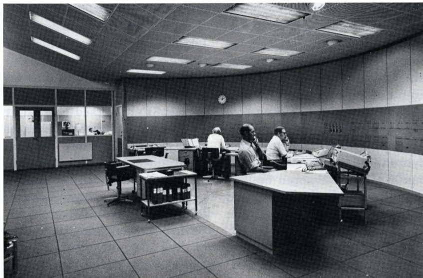
Signal- og sikringsanlæg har altid været oplagte rationaliseringsfelter. Billedet viser Gøteborgs fjernstyringscentral, da SJ's rationaliseringsarbejde var på sit højeste. »Kong« rationalisering glemte »bare«, at personale ældes – ny-uddannelse hører med i billedet.
