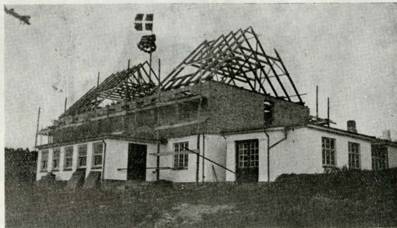
Rejsegilde under ombygningen 1939—41.
