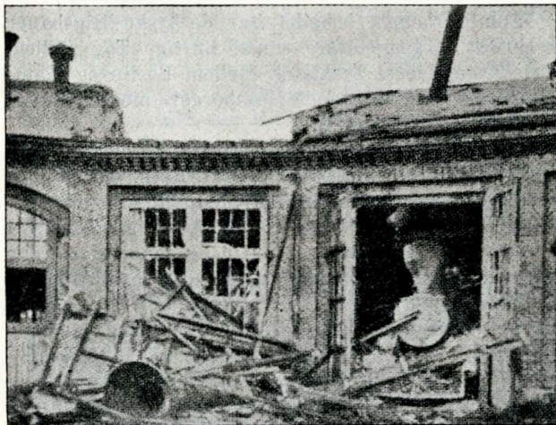
Lokomotivremisen efter Eksplosionen.
