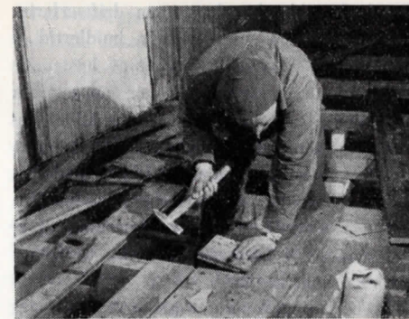
Der lægges gulv.
