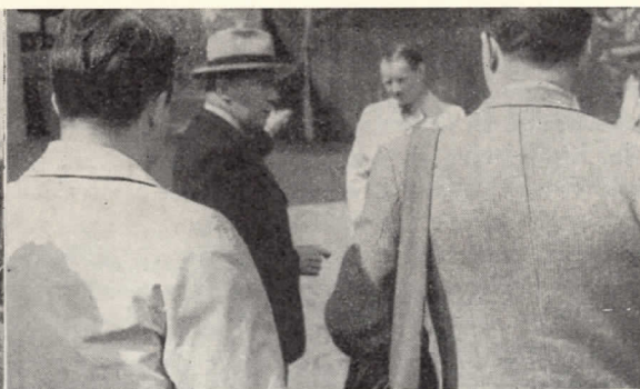
Hr. første maskiningenør Rydberg fra Stockholm-Roslagens Järnväger forklarer lidt om Östra station.
