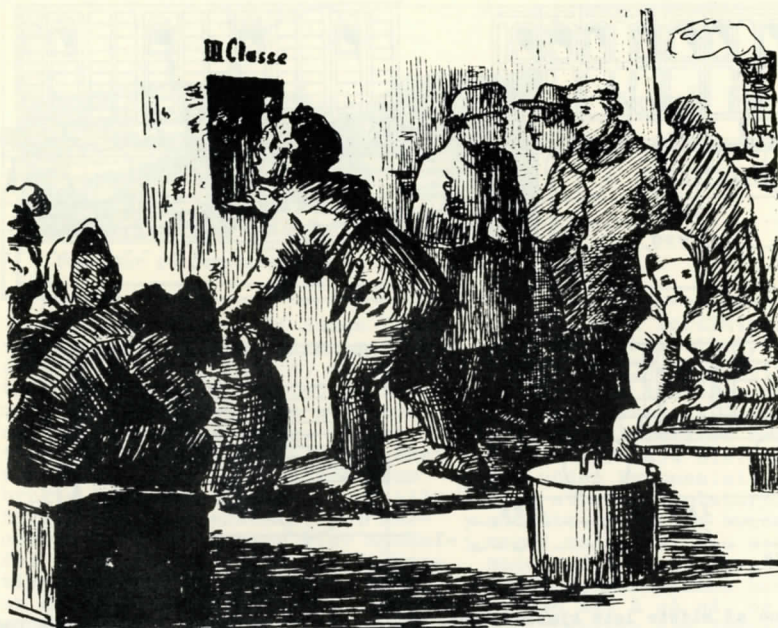
Ekspedisjons- rum i Oslo gl. stasjonsbyg- ning. "Er e dette hølle jeg skal i- gjennem for å komme på trea plas på banen?" Efter Diriks.
