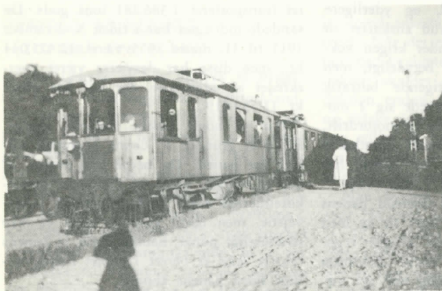
RGGJs M2 og bagved M4 på Tornled station.
