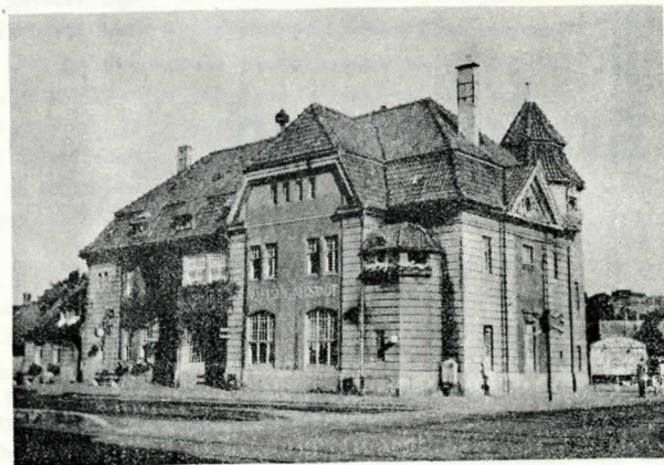
Stationsbygningen i Schleswig Altstadt.
