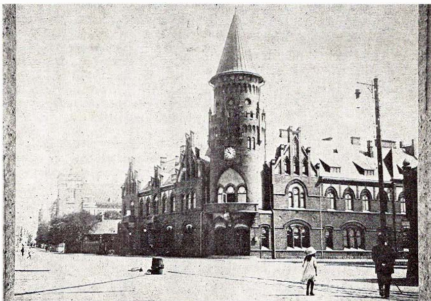
Banegården Trelleborgs Nedre, senere Trelleborg Centralstation, siden 1970 lukket for passagertrafik. Foto: Trelleborgs Museum.
