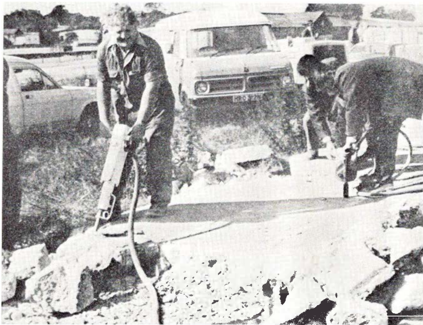
Betonhammeren »PACEBRAKER« i aktivitet i betondække.
