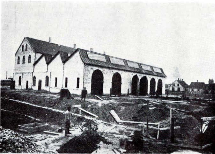
Maribo. Banens nye værkstedsbygning under opførelse 1906. Arkiv: -tl-.
