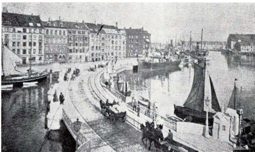
Børsbroen med sporforbindelse til Havnegade 1880-1933
