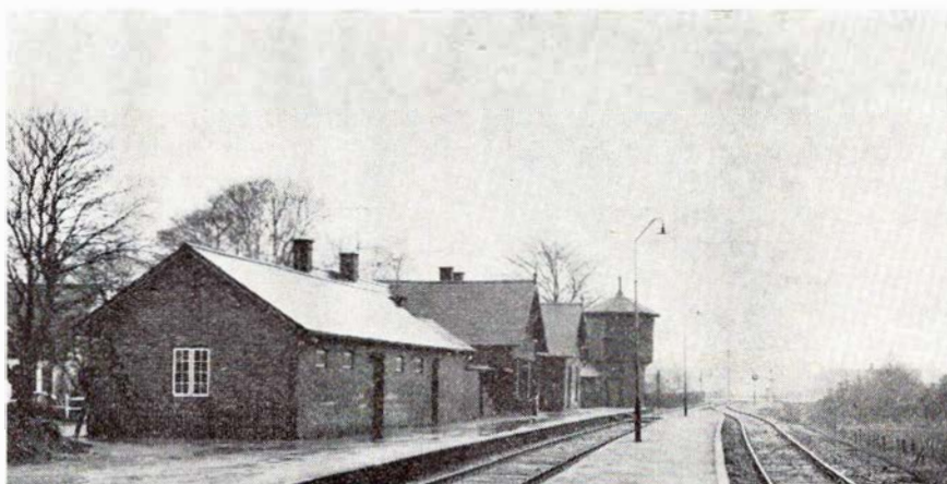
Stenstrup station med vandtårn. Foto Finn Sørensen
