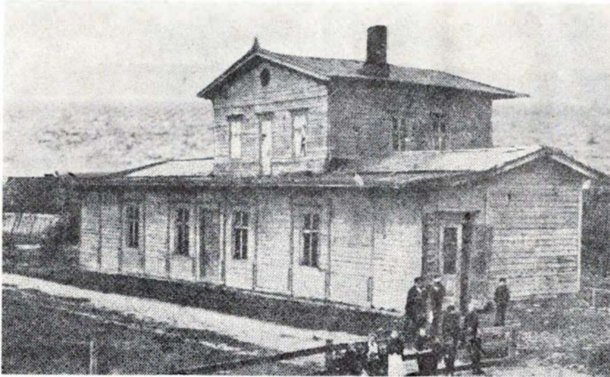
Valby første station for nedrivningen ca. 1900
