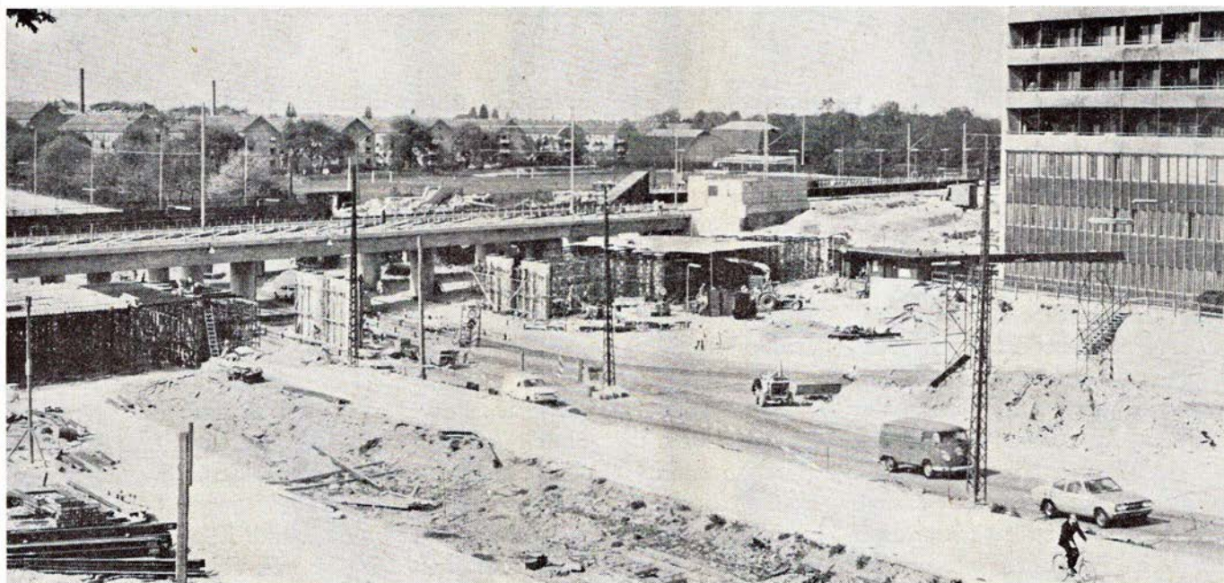
Underføring for Lyngbyvej udført for og efter projekt af D S B
