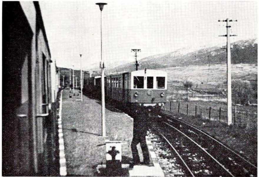
Krydsning midt i Pyrenæerne. Bemærk EL-skinne t.h. for sporet
