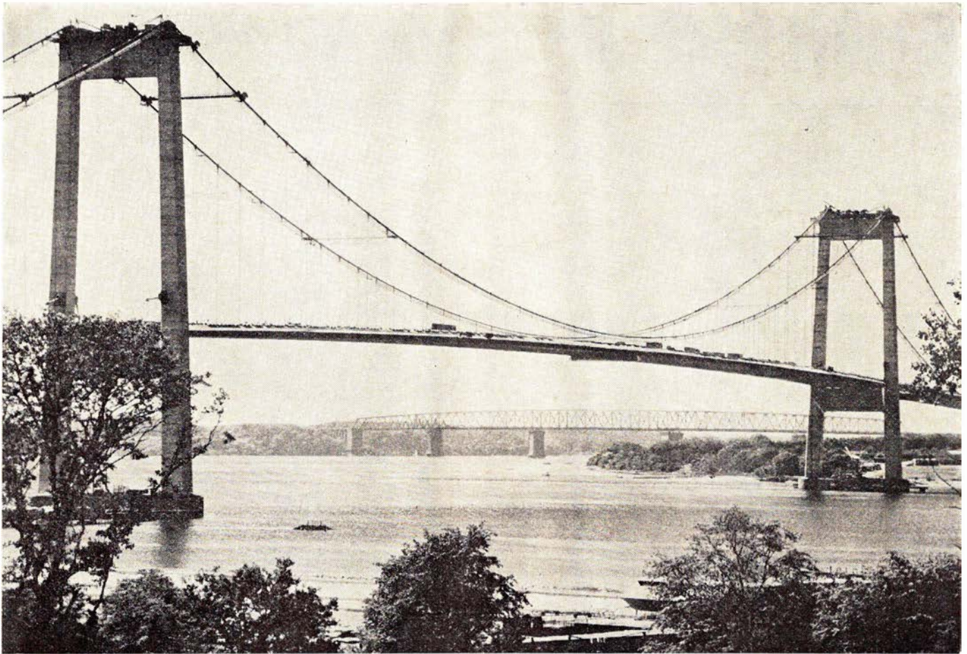
Cirka 375.000 m 2 stål er på den ny Lillebæltsbro rustbeskyttet med 480.000 kilo Dyrup Stålhudsmalinger.
