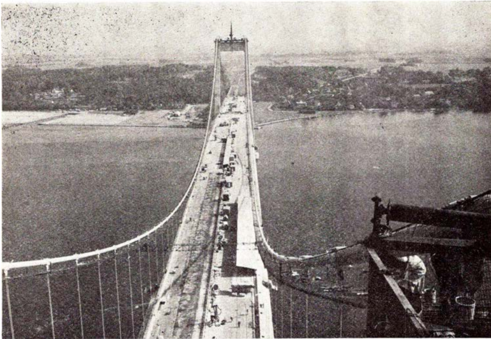
Før broen var færdig
