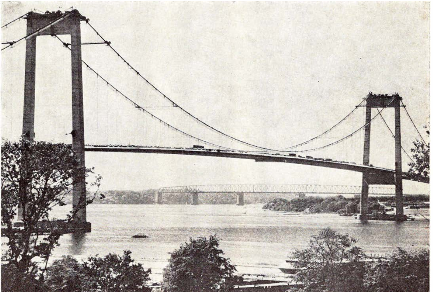
Cirka 375.000 m 2 stål er på den ny Lillebæltsbro rustbeskyttet med 480.000 kilo Dyrup Stålhudmalinger.
