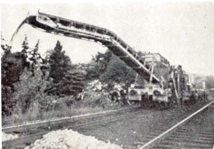
Ballastrensemaskine i arbejde
