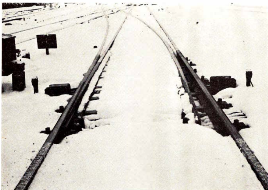
Elektrisk opvarmning af sideskinne alene. Billedet taget under snefald og \pm 5^{\circ}\text{C} . Her kan varmen ikke forplante sig til tungen
