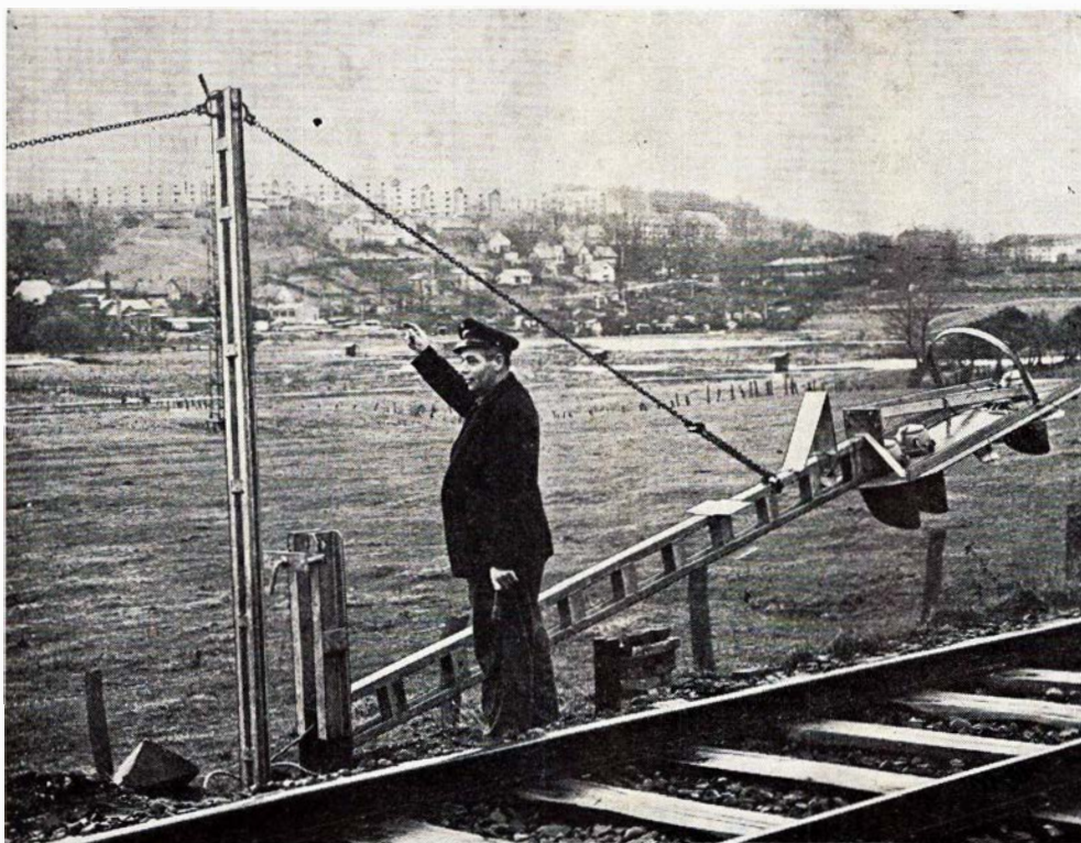
Rejsning af dagslyssignal på strækningen: Kolding-Lunderskov
