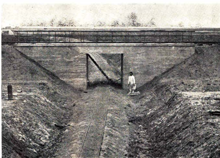
Mergelviadukt under Troldhedebanen
