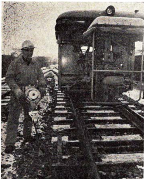
COBRA'en vil især være til stor hjælp, hvor en svellestampningsmaskine, ikke er til stede
