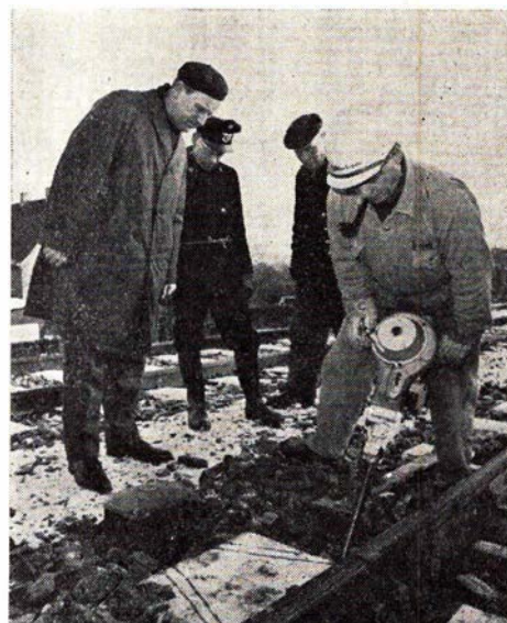
Aing. H. O. Petersen besigtiger med anerkendende blik ballaststopning med »COBRA«
