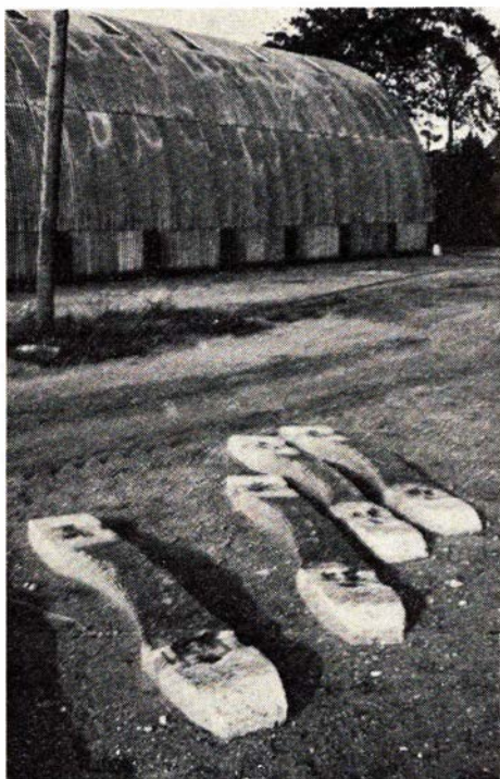
Betonsveller fra ca. 1917 Nylig optaget på Taulov st. Foto: Bent Hansen, Eltang
