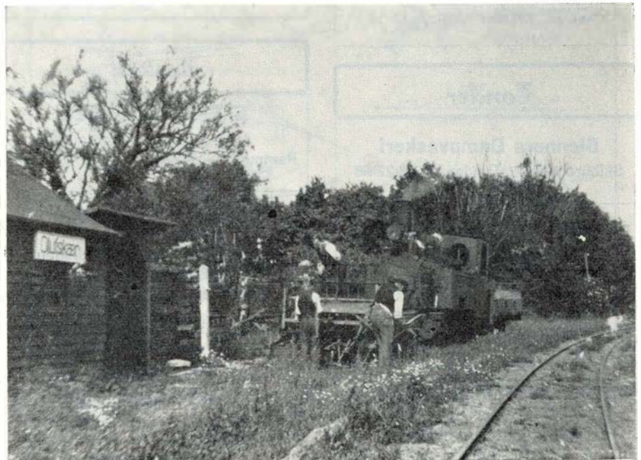
Ballastrensetog ved Olufskær holdeplads
