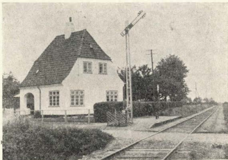
Kragenæsbanens signal for passage af roebanen
