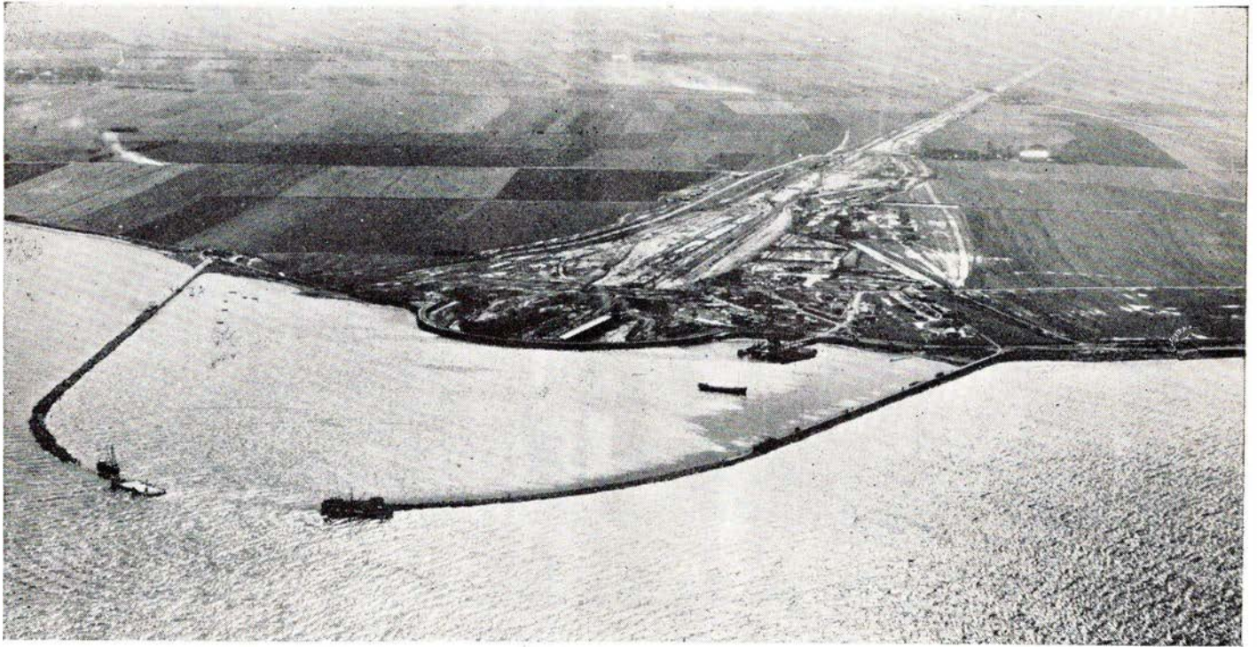
Færgehavnen i Puttgarten under opbygningen.
