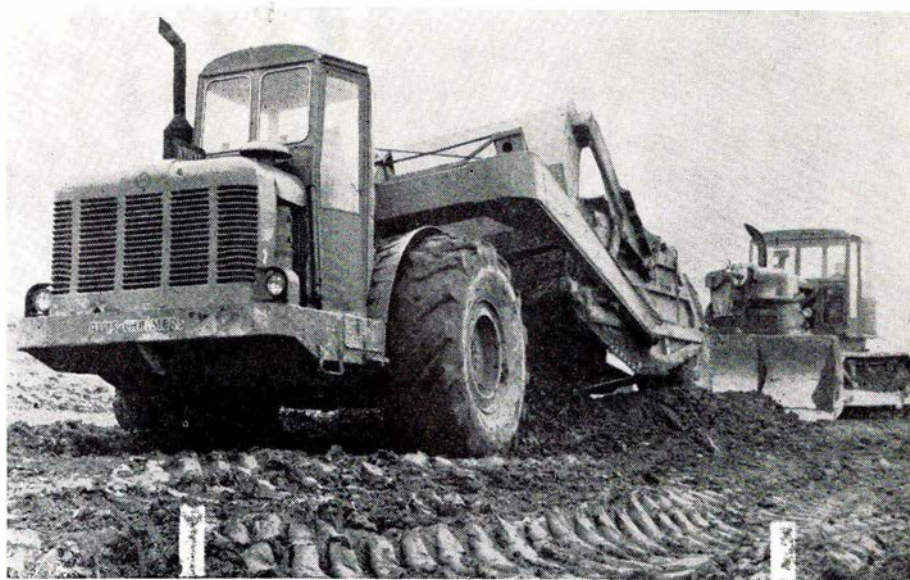
Fig. IX. Scrapers, der samler jorden som i en vom efterfulgt af bulldozer.
