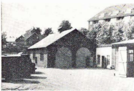
Gemt i et autoværksted ligger endnu Egtved-remisen
