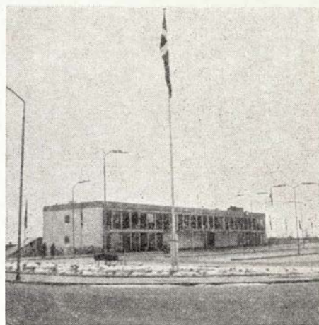
Den nye stationsfacade til gaden
