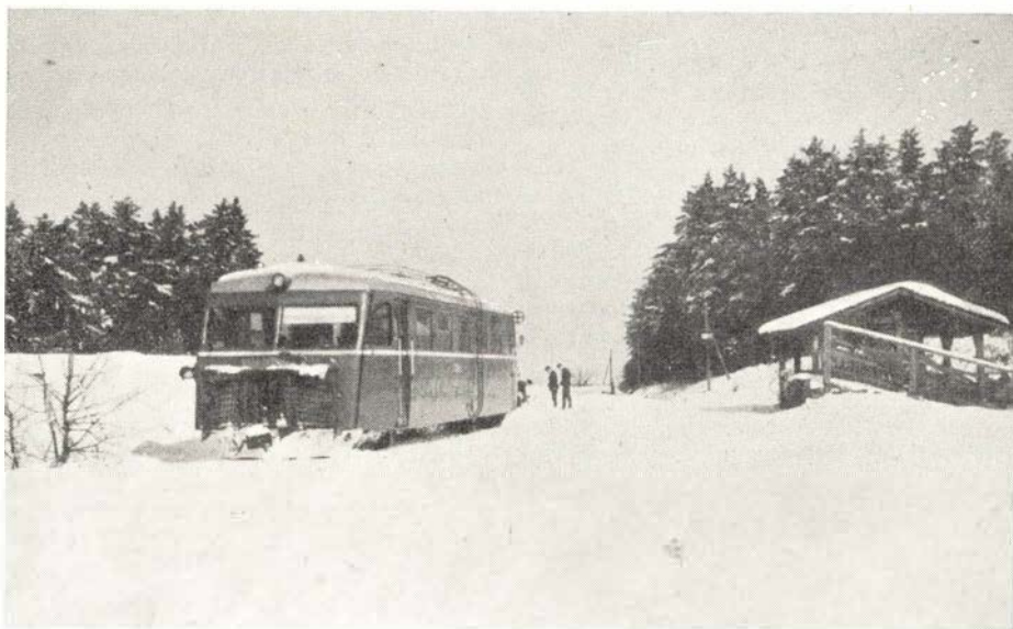
Det kneb med at finde sporskiftet på Ørn- høj station
