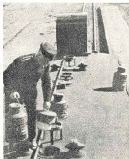
Der fyldes på personvognens olielamper på taget af vognen
