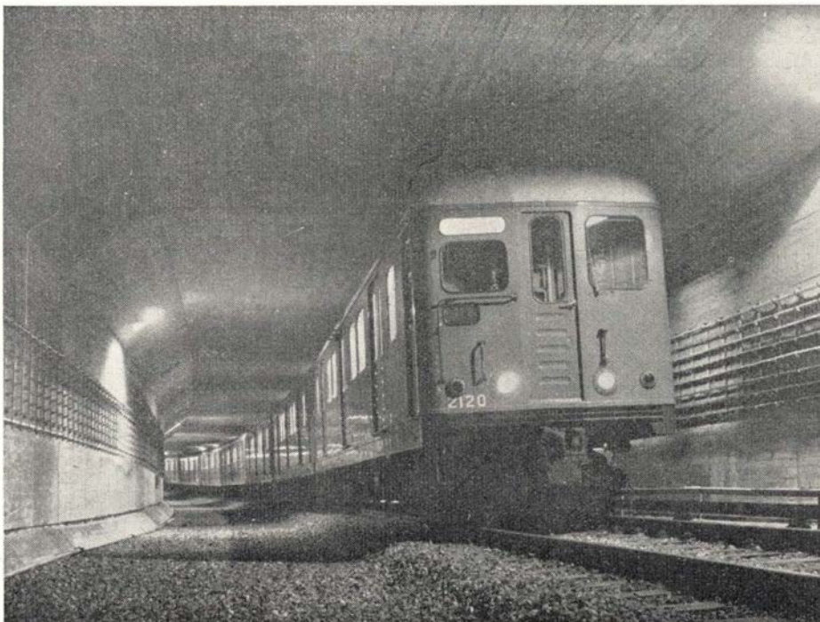
Tunnelbanetog. Bemærk døren i vogngavlen samt pladsen til dobbeltspor
