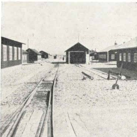
»Hovedbanegården« i Agger set fra vest. Bemærk det tungeløse sporskift.
