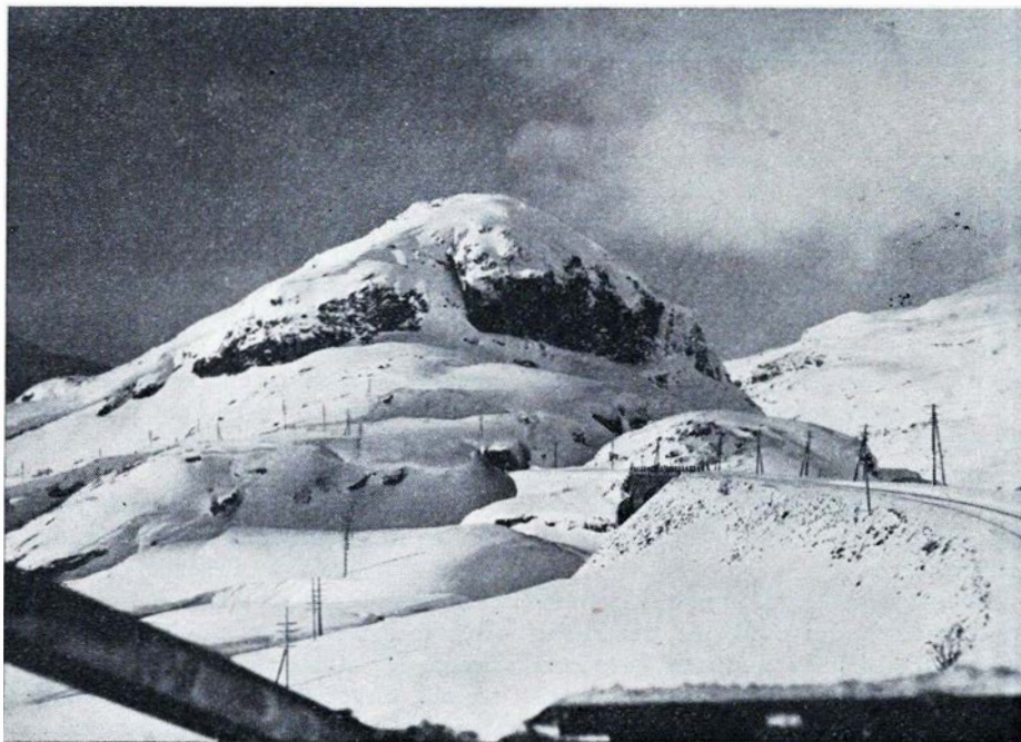
»Gravehals-tunnelen« mellem Myrdal og Vatnehalsen på højfjeldet ca. 1100 m o. h.
