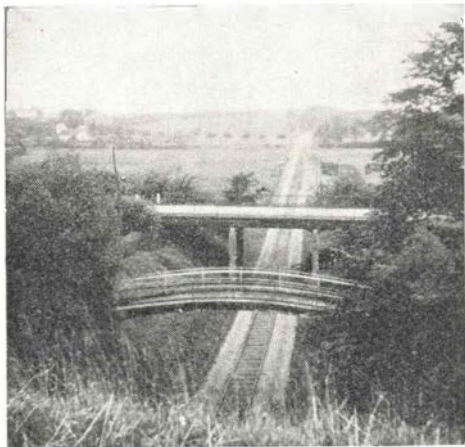
— langt er der ned til Troldhedebanens spor i dalens bund
