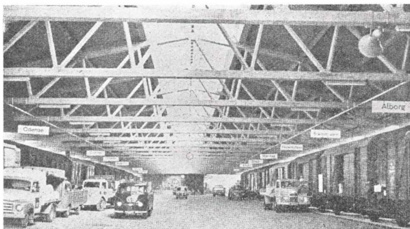
Københavns Godsbanegård, tagkonstruktion over nyt pladsbelæsningsanlæg af gitterdragere med 20 m spændvidde.
