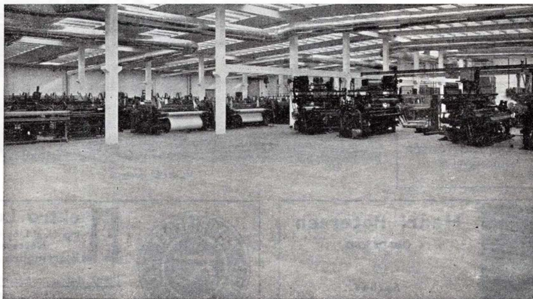
5 000 m 2 ALIFA DB behandlet betongulv i et bomuldsspinderi.
