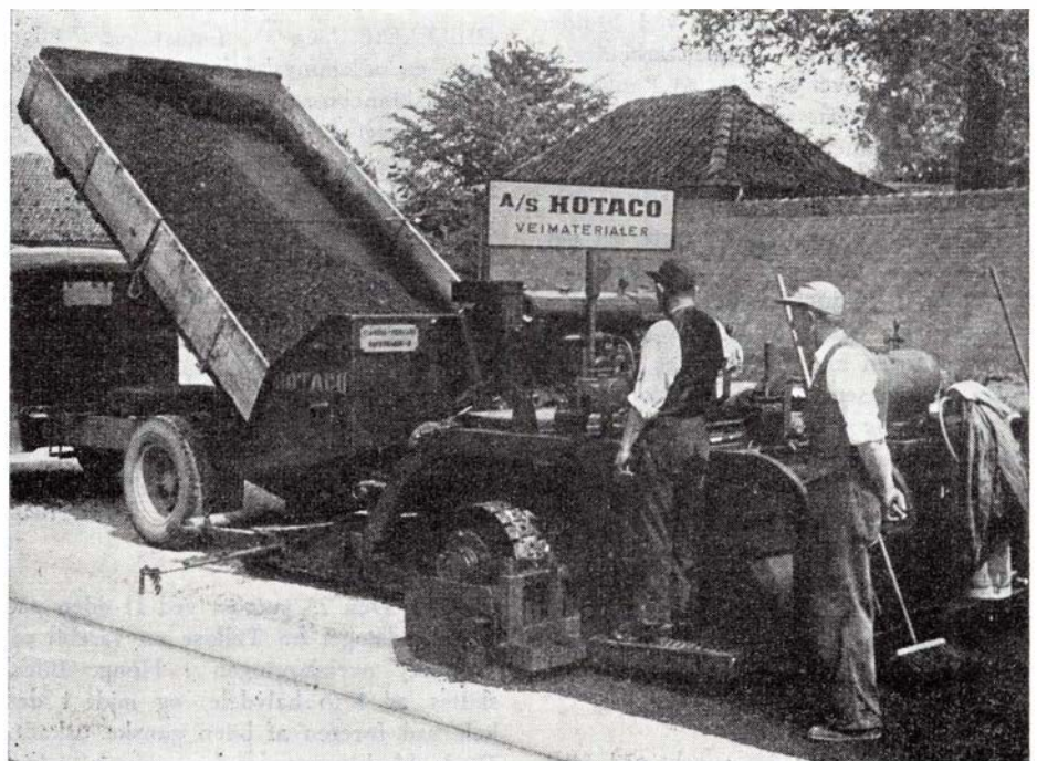
A/S HOTACO's moderne vejbelægningsmaskine, der udlægger 200 tons asfaltbelægning pr. dag.
