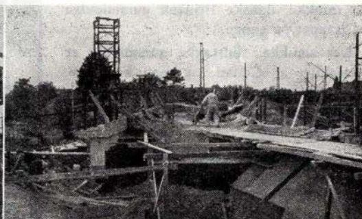
Bygning af bro på Valby st.
