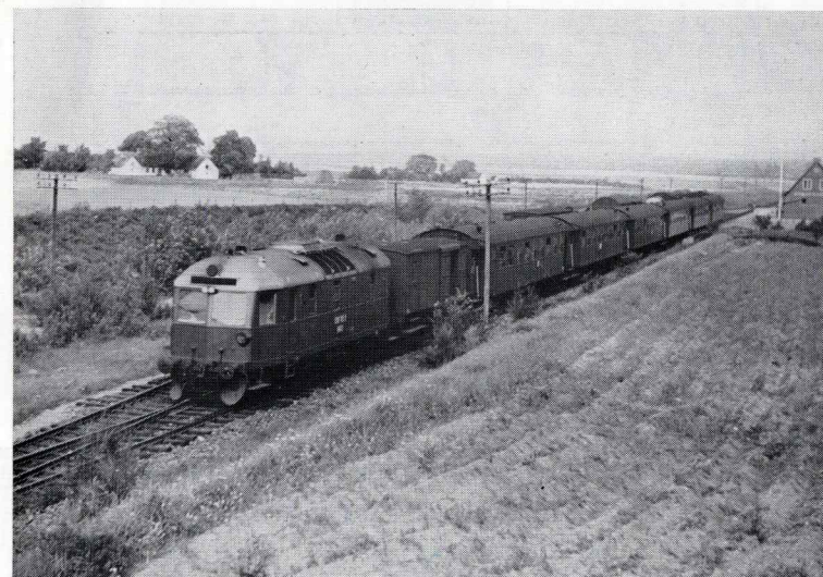
M 8 under krydsning ved Brødeskov station
