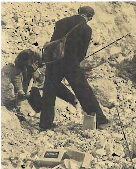
Sprængerer lader et hul. Foto fra 1943.
