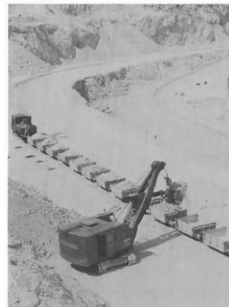
Gravkoen har afløst håndkraft ved læsning af jernbanevogne.
