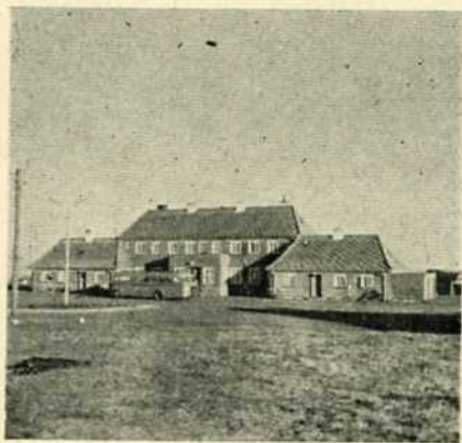
Nuværende stationsbygning i Hirtshals er imponant
