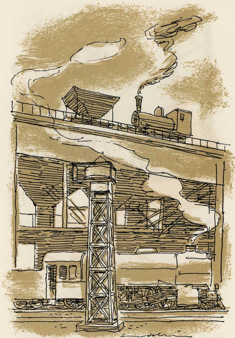
I røg og damp fyldes kullene på maskinen fra den store kulsilo ved hovedremisen . . .
