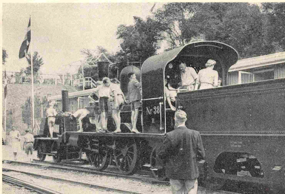
Damplokomotivet har stadig ungdommens interesse.
