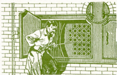
Angestregtes Durchstoßen der Rohrbürste. Wöchentlich nur einmal, wegen zu langer Zeitdauer, 1/2-1 Stunde
